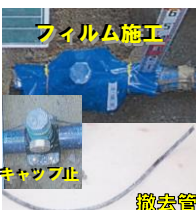
引込管撤去状況 (キャップ止/フィルム施工/撤去管)
