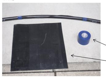
ゴムシートは企業団指定品を使用する。 ロケーティングワイヤーは、ゴムシートを 巻き付ける前に水道管に取り付ける。
