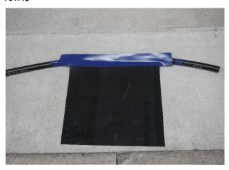
ゴムシートの端に防食テープを貼り、水道 管に固定する。防食テープはゴムシートの 幅より大きく貼り付ける。
