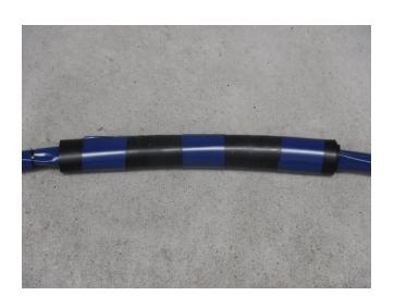
ゴムシートを巻き終えたら、両端と中 央部分の計3箇所を防食テープで固定 する。ゴムシートは、たるまないよう必 要に応じて固定箇所を追加する。
