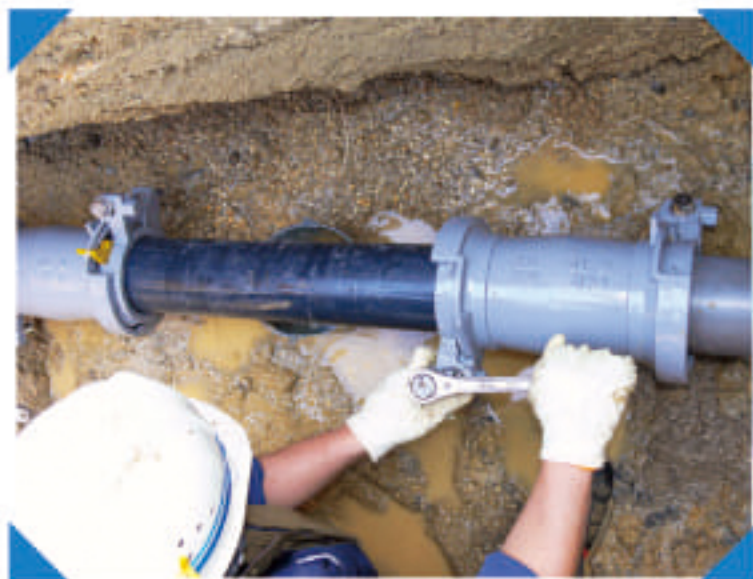
配水管の水もれを修理しています。
