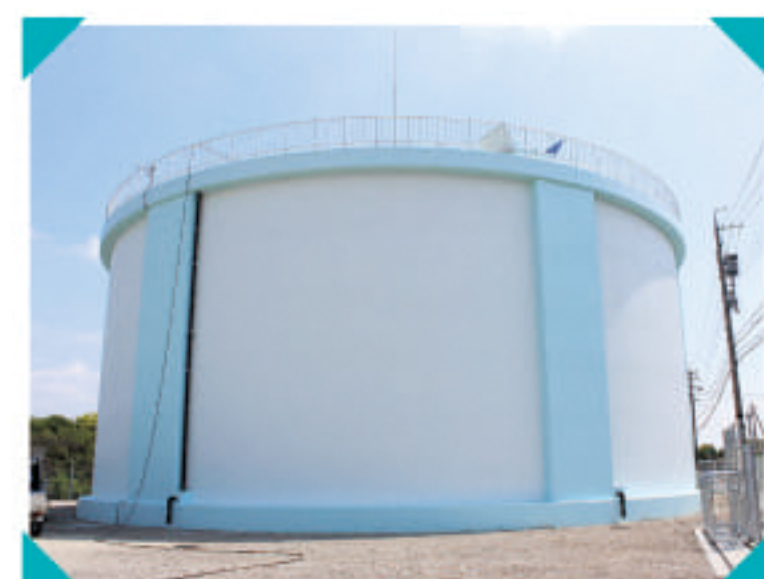
いつでも水が使えるように、配水池を管理しています。
