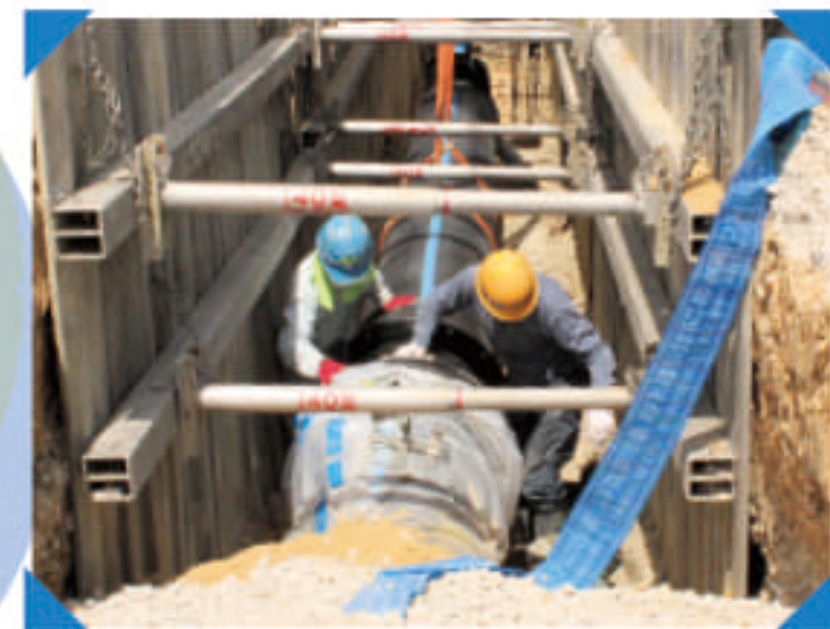
配水管を延ばす工事をしています。
