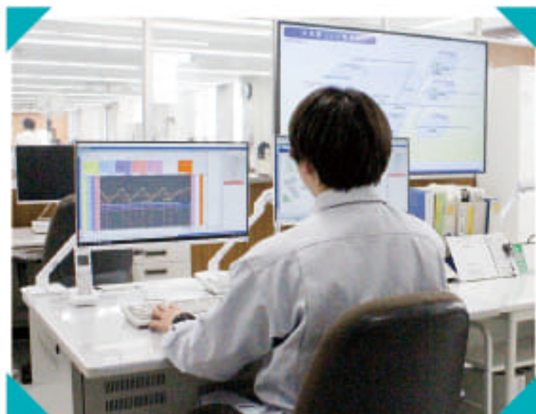
中央管理室では、配水池や取水施設の状況を監視しています。
