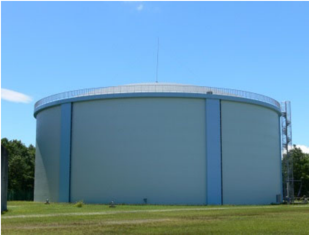
三ヶ峯配水場
